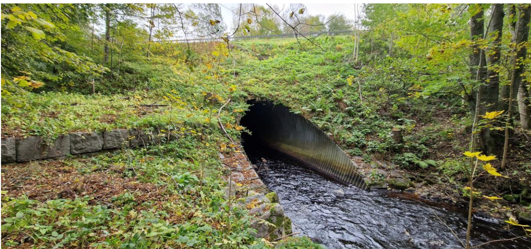
Figur 17. Foto på trumman uppströms, på västra sidan om Hjövägen.
