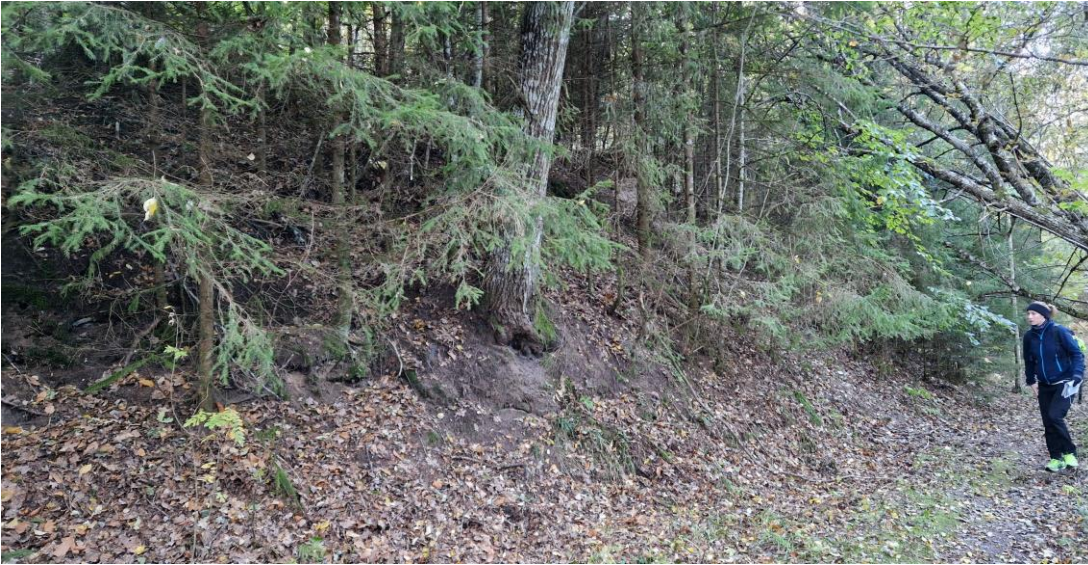
Figur 62. Foto med vy västerut på gångvägen i östra delen av området. Slänten är schaktad brantare för att få plats med gångvägen och passage för ledningen. Släntkryp pågår.
