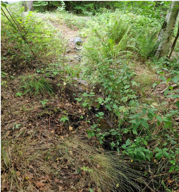
Figur 43. Foto med vy söderut i dräneringsdike direkt väster om befintligt avloppsreningsverk.
