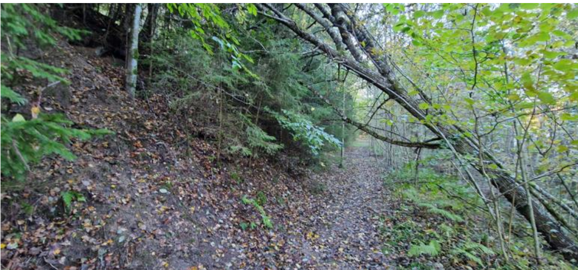
Figur 12. Foto med vy västerut. Slänten är schaktad brantare för att utforma vandringsleden samt passage för ledningen. Släntkryp pågår.
