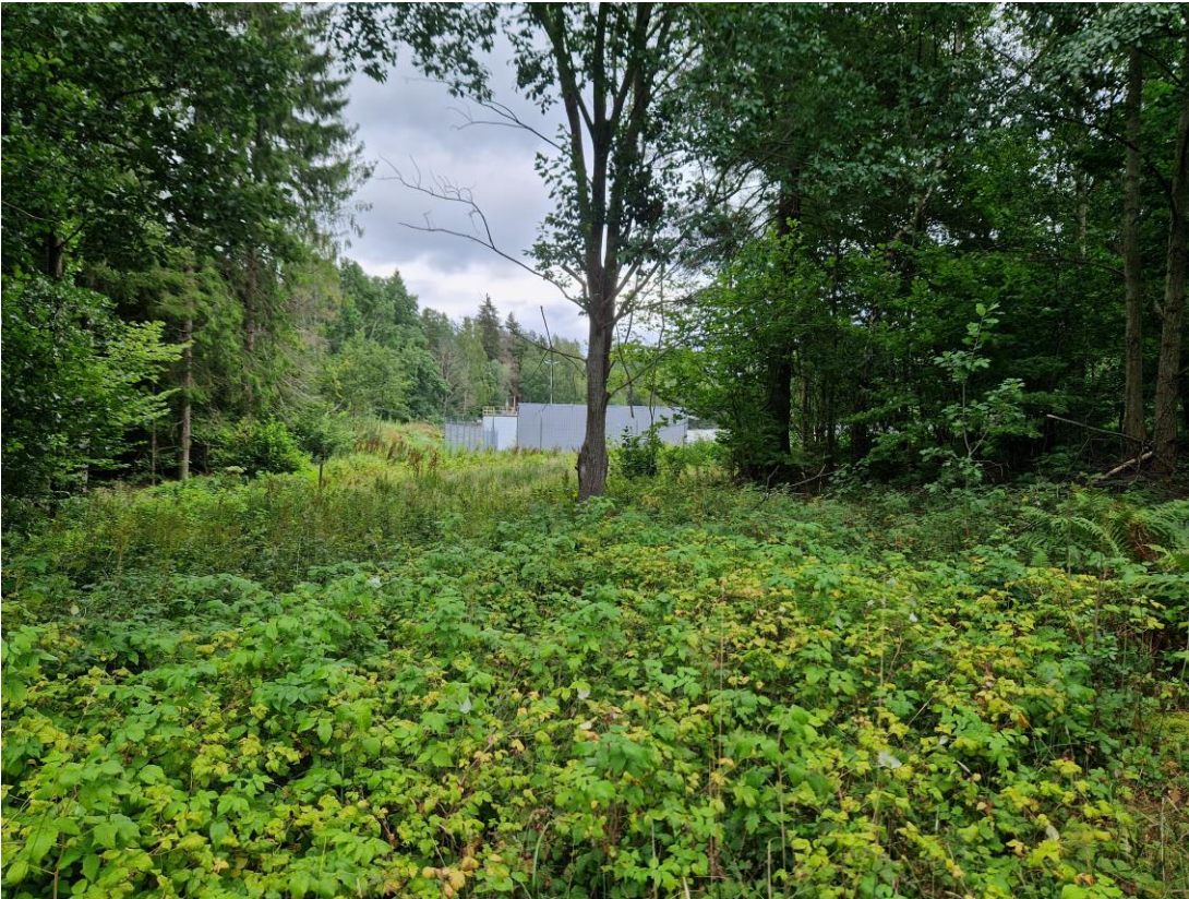
Figur 42. Foto med vy österut mot befintligt avloppsreningsverk.
