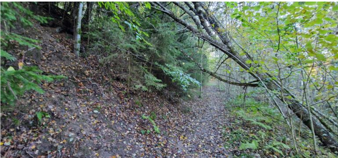
Figur 63. Foto med vy västerut på gångvägen i östra delen av området. Slänten är schaktad brantare för att få plats med gångvägen och passage för ledningen. Släntkryp pågår.
