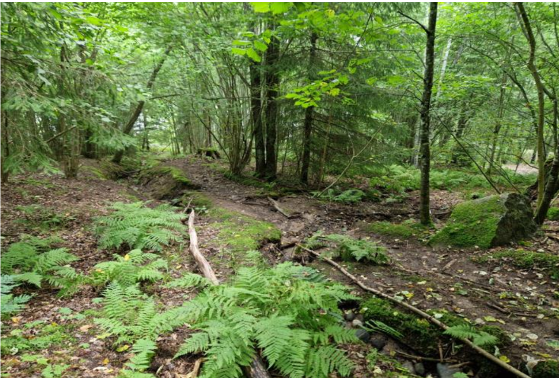
Figur 10. Foto med vy norrut där diket delar sig i två, i slänten söder Habo ARV. Observera erosionsskador.
