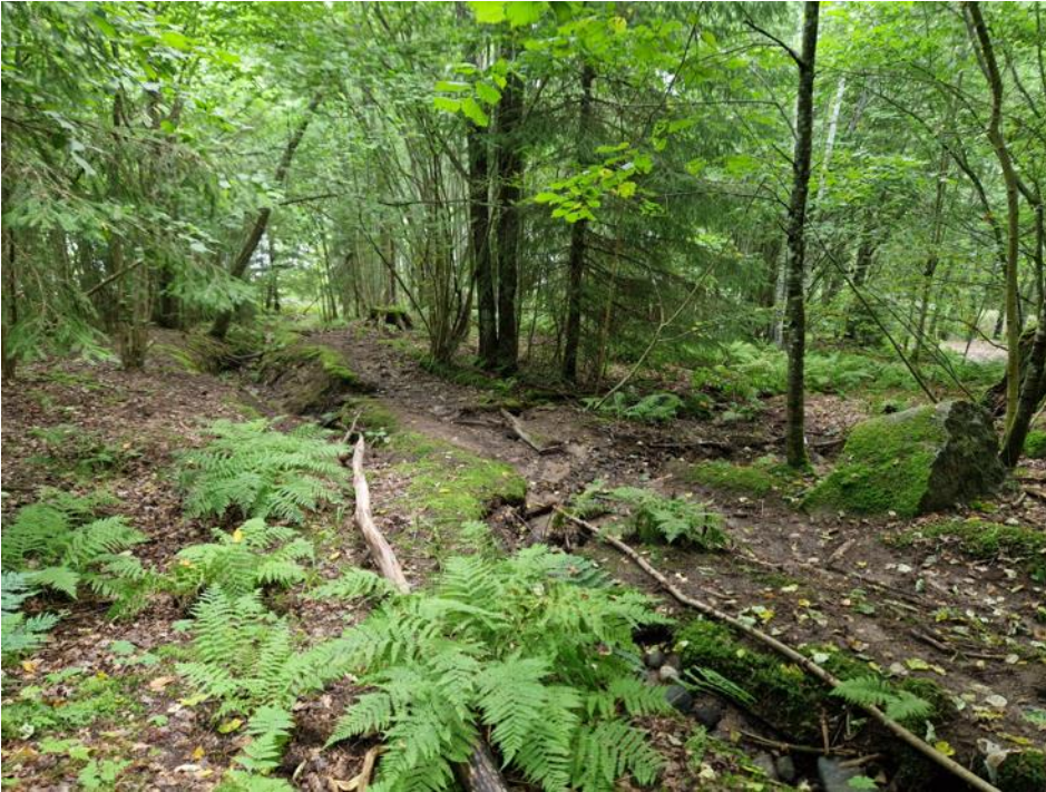
Figur 58. Foto med vy norrut på där ena diket delar sig i två, i slänten söder om avloppsreningsverket. Tydliga tecken på erosionsskador.
