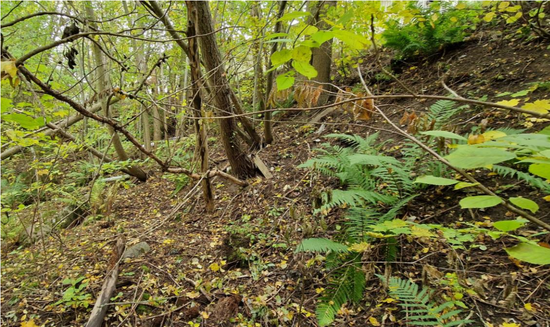
Figur 14. Foto med vy söderut på den övre delen av slänten mot industrifastigheten NordIQ Habo.
