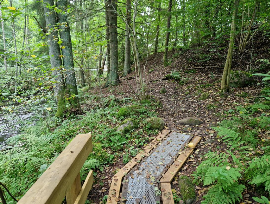
Figur 34. Foto med vy österut på slänten mellan Hökesån och avloppsreningsverket. I bakgrunden går en ledningsbro över Hökesån.
