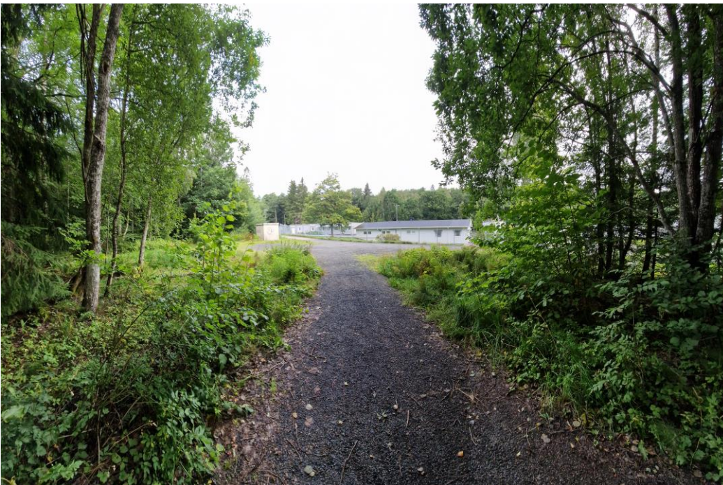
Figur 53. Foto med vy mot nordväst på reningsverket.
