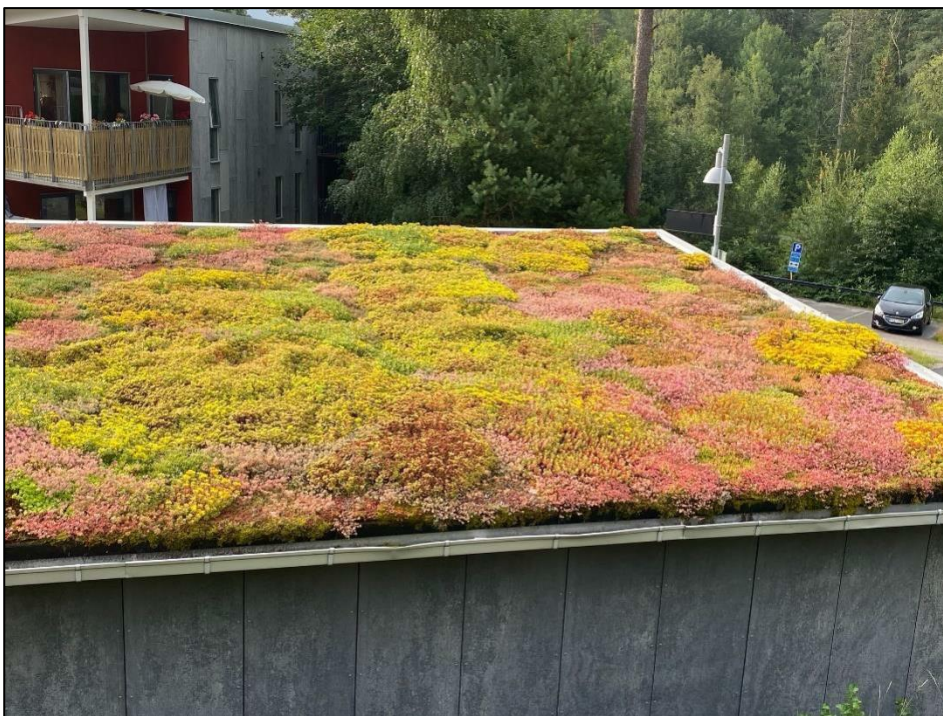
Figur 30. Grön takbeläggning. Bildkälla: Sweco
