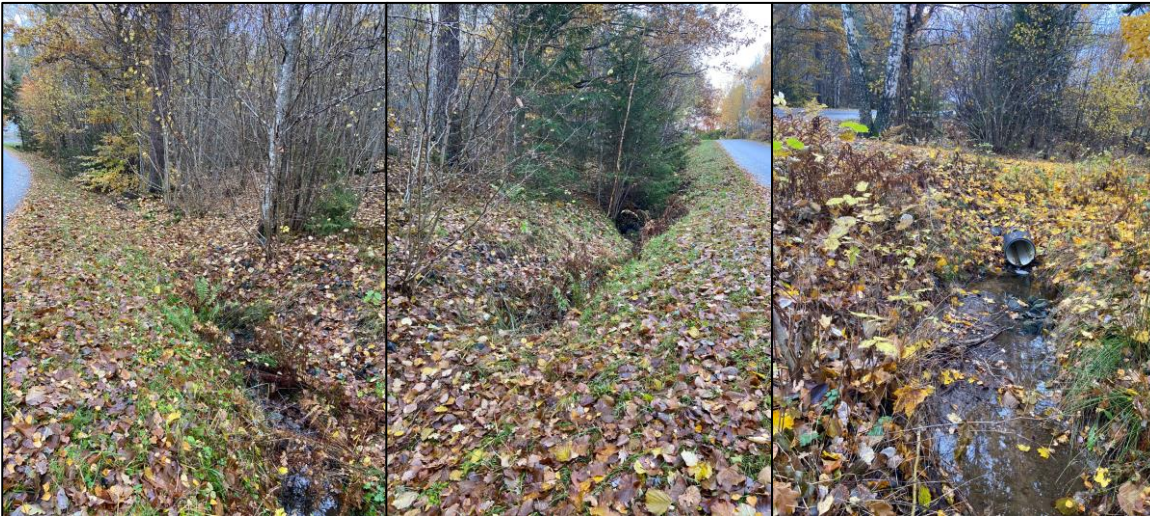
Figur 17. Vänster bild: Östra sidan av Dalvägen. Mittenbild: Västra sidan av Dalvägen. Högra bild: Trumma (BTG 400) under grusväg. Bildkälla: Habo kommun
