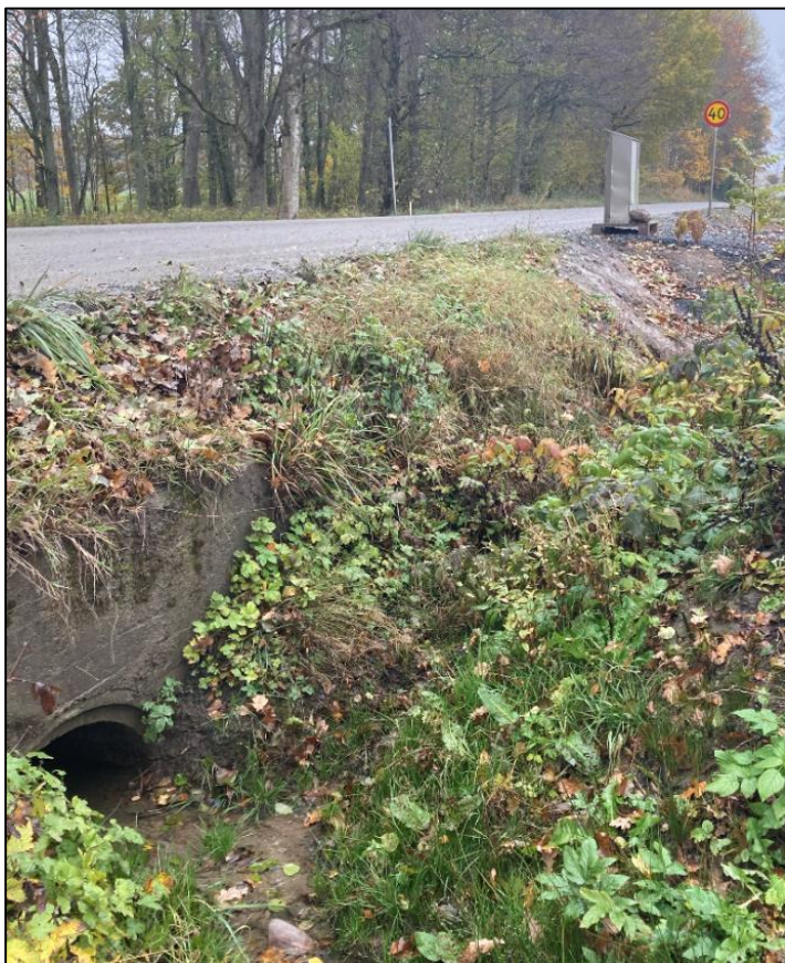
Figur 10. Befintlig trumma under Tumbäcksvägen, fotad under platsbesök
