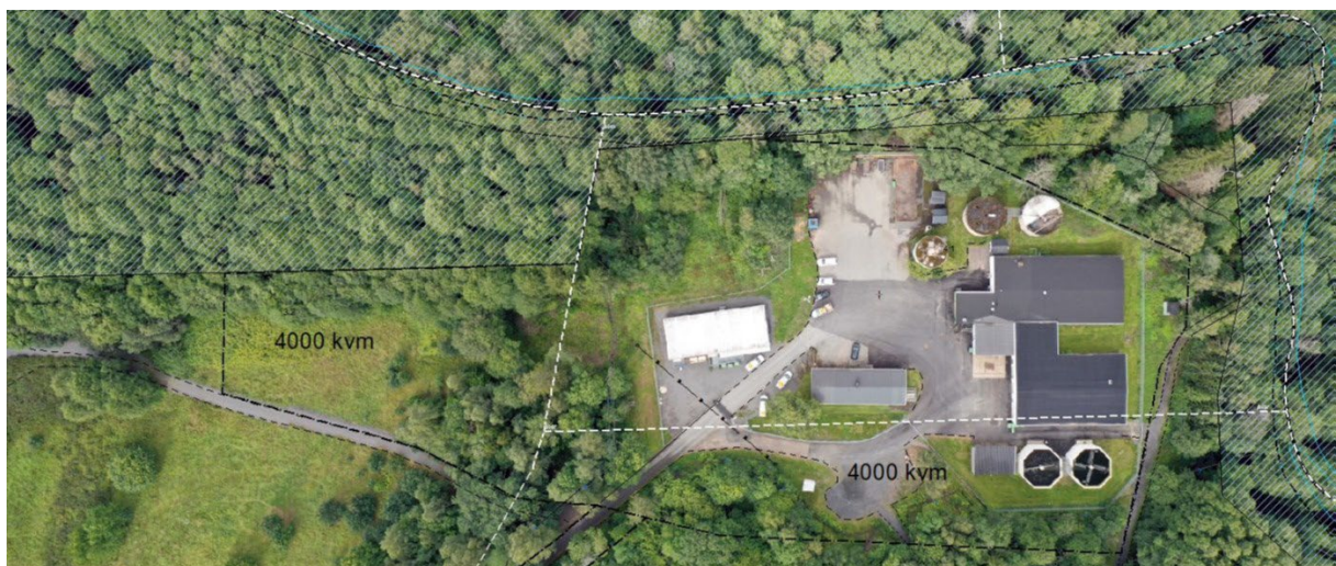
Figur 10 Foto över reningsverkets utbredning idag tillsammans med de nya ytor som är tänkt för expansion.
