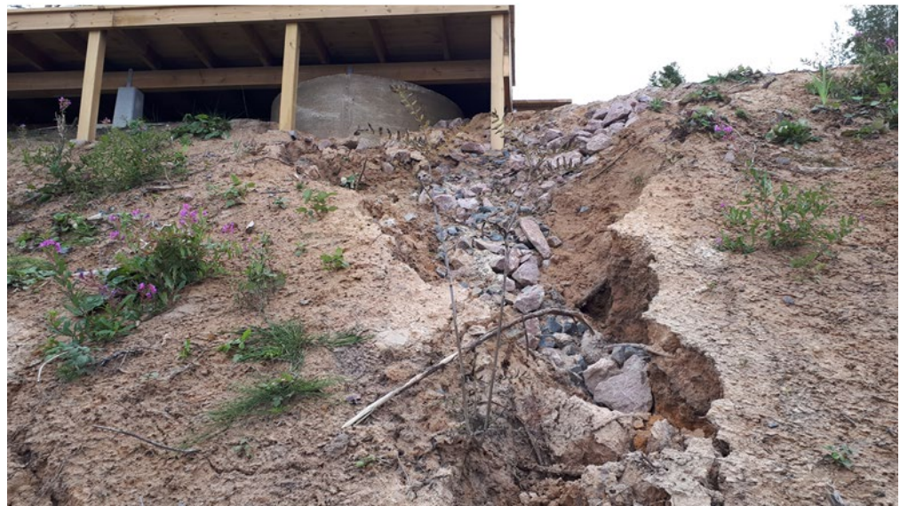
Ytvattenerosion vid grundkonstruktion för trädäcket, vy mot väster
