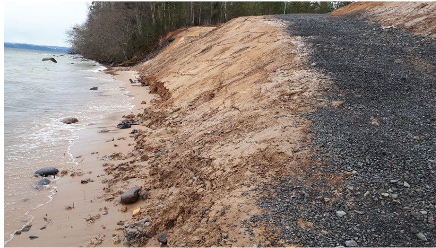
Begynnande erosion av släntfot, vy mot söder
