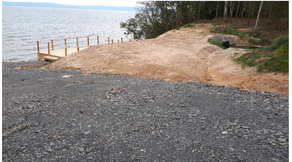
Avskärande dike ner till damm samt upplagda massor ovan trädäck, vy mot sydost
