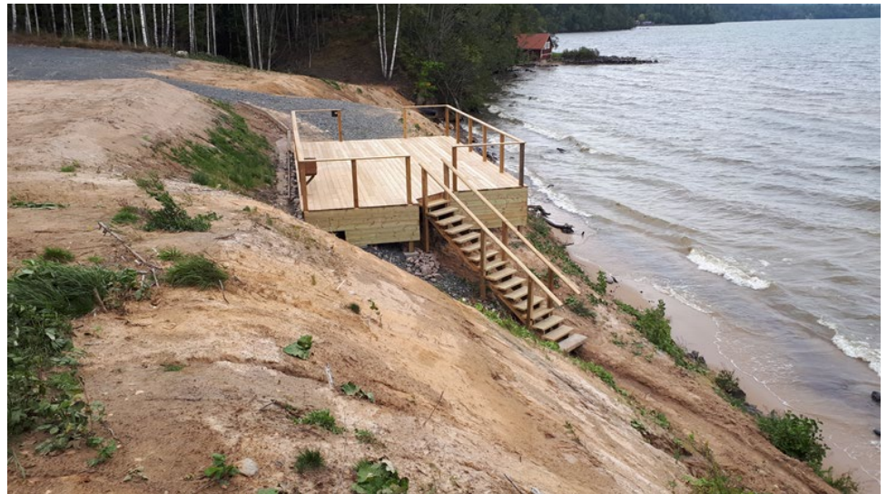
Trädäcket med trappa, vy mot norr
