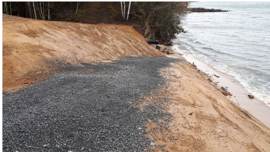
Schaktad anlagd väg i slänt ner till stranden, vy mot norr
