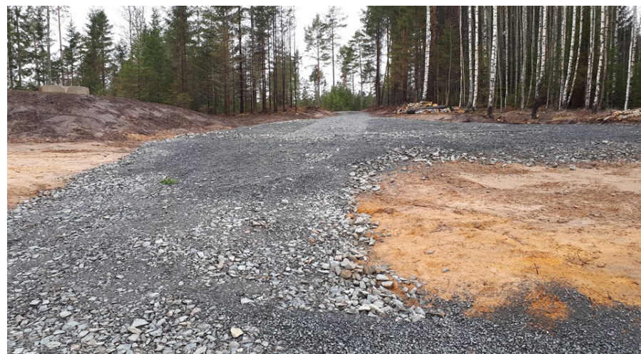
Schaktning av anlagd skogsbilväg med vändplan ner till Vättern, vy mot väster
