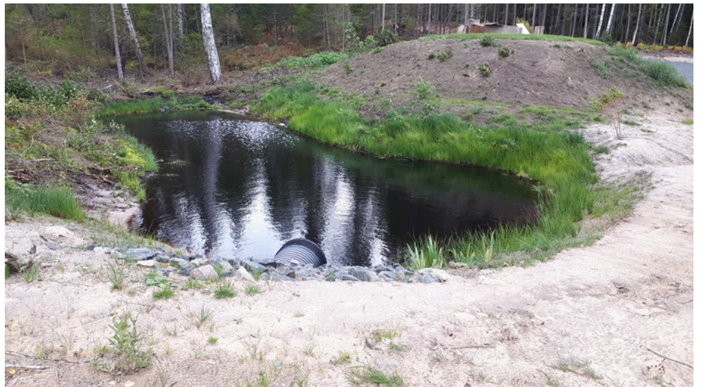
Anlagd damm med utloppsror till slänt i söder, vy mot väster
