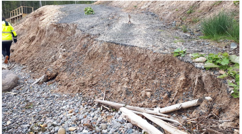
Väg samt slänt i strandlinjen, vy mot söder
