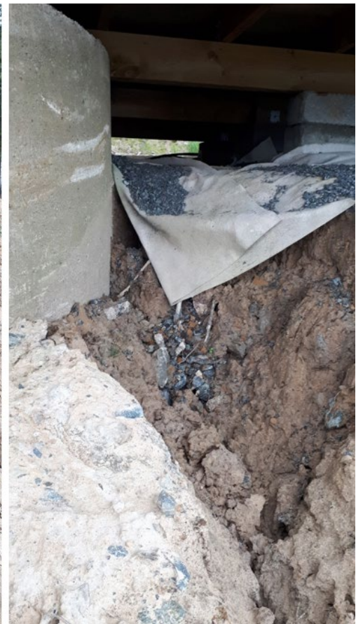
Ytvattenerosion betongfundament
