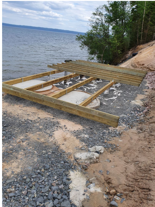
Påbörjat arbete på trädäcket
