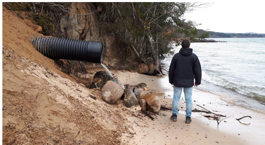
Igenfyllnad av bäckravin samt kulvertering av bäck, vandringshinder för vattenlevande organismer och fisk vid norra delen av schaktningen, vy mot norr
