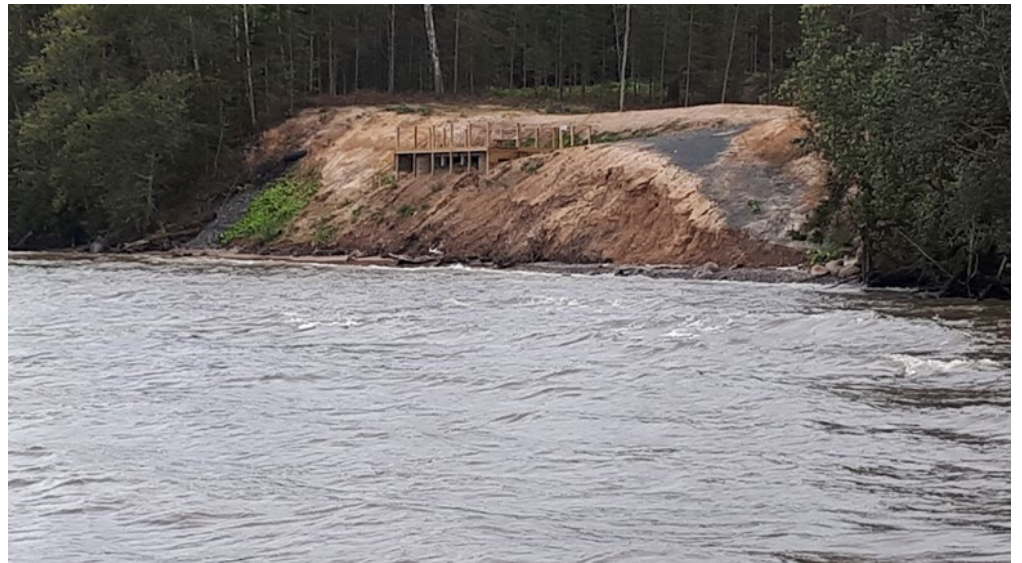
Schaktområde, vy mot sydväst
