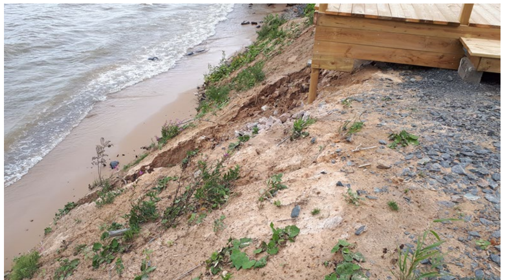
Ytvattenerosion vid grundkonstruktion för trädäcket, vy mot söder
