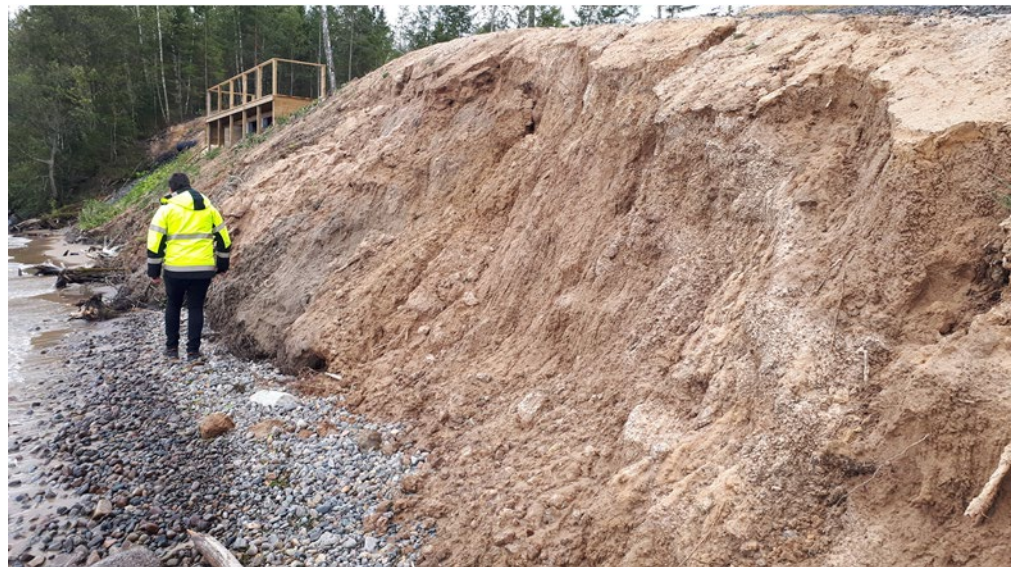
Våg- och vattenerosion av släntfot, erosionshöjd cirka 4-5 meter, vy mot söder
