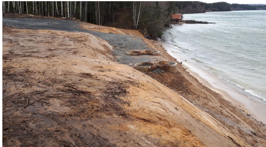
Schaktad slänt vy mot norr
