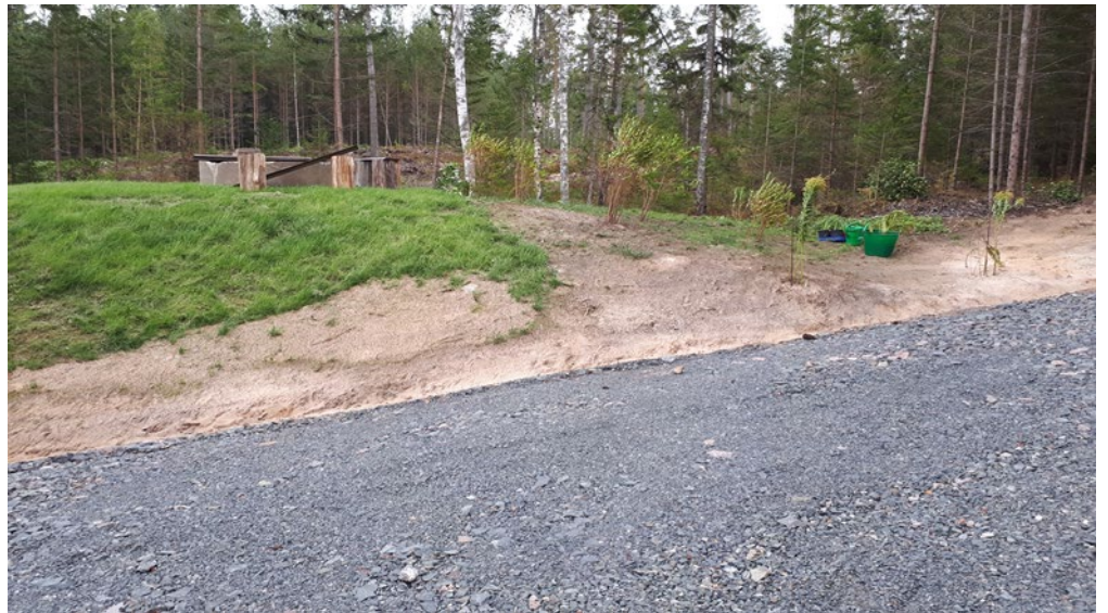
Grillplats på anlagd kulle, vy mot söder
