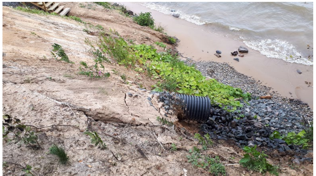
Vägtrumma med utlopp i slänt från anlagd damm, vy mot norr
