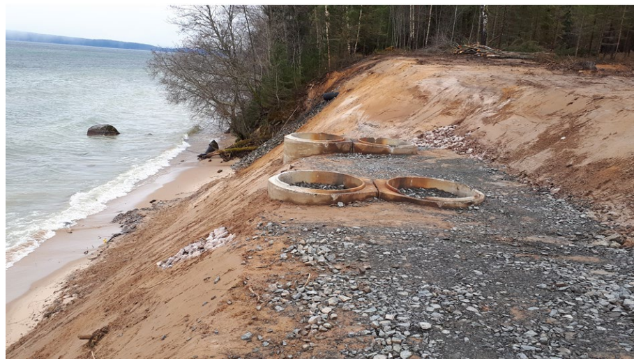
Schaktad slänt med betongrör som fundament i slänt, vy mot söder
