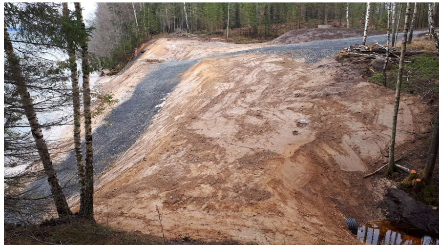
Igenfyllnad av bäckravin och kulverterad bäck, vy mot söder
