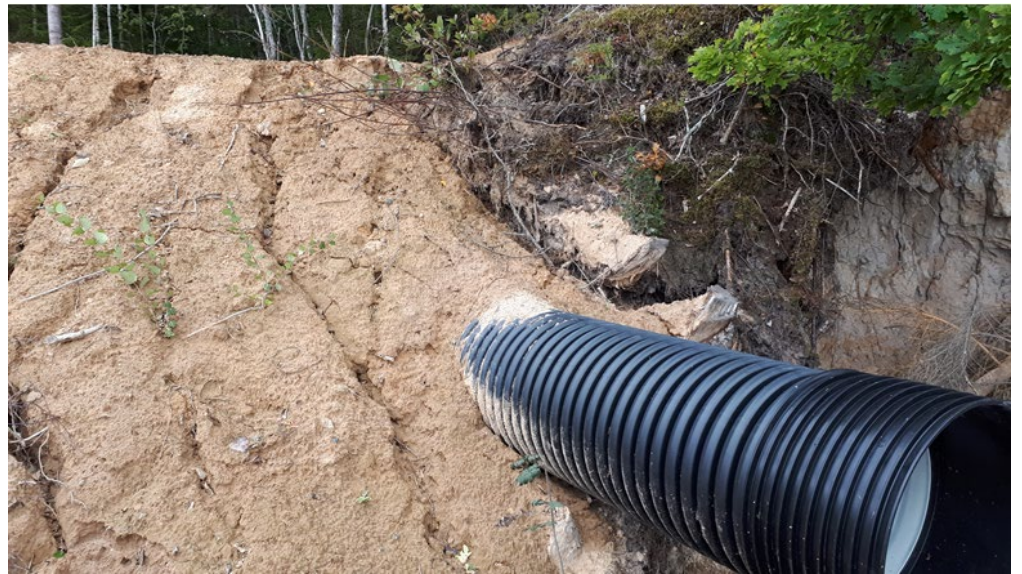
Erosion i anslutning till anlagd trumma vid kulvertering av bäck i norra delen av området, vy mot väster
