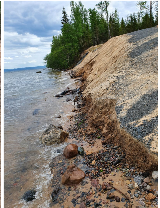
Begynnande erosion av släntfot, vy mot söder
