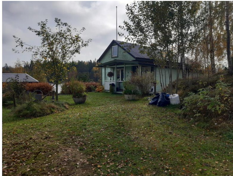
Byggnad 8 (Byggnadsår 1960, suterränghus)
