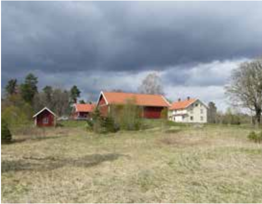
Mangårdsbyggnaden (Västerkärr 1:64) med tillhörande lygelbyggnader vid Västerkärrs gård ligger på en höjd i landskapet.
