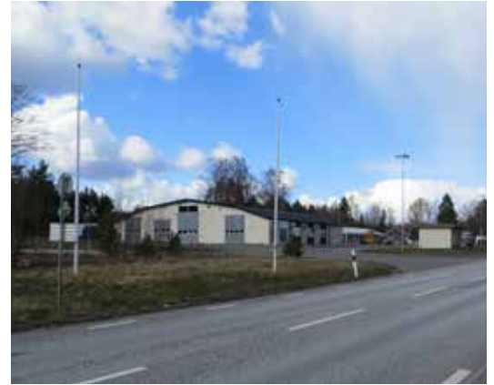
Vägkorsningen med bussgaraget (Brandstorp 1:87) från tidigt 1960-tal till vänster.
