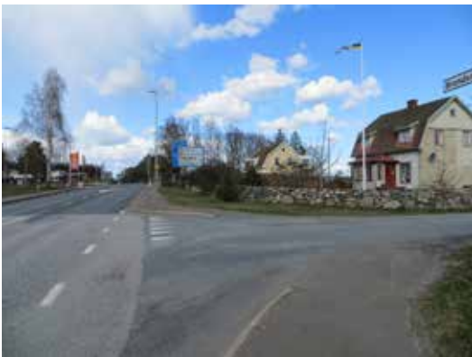
Utmed genomfarten ligger några av ortens äldsta bostadshus från 1930- och 1940-talen, varav lera har en välbevarad exteriör. Närmast i bild ses huset som tidigare inrymde konsum (Brandstorp 1:23).
