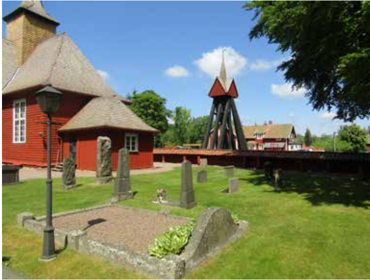
Brandstorps kyrka och den fristående klockstapel. I bakgrunden ligger kyrkskolan, som ursprungligen uppfördes 1847, men som senare förändrats väsentligt.
