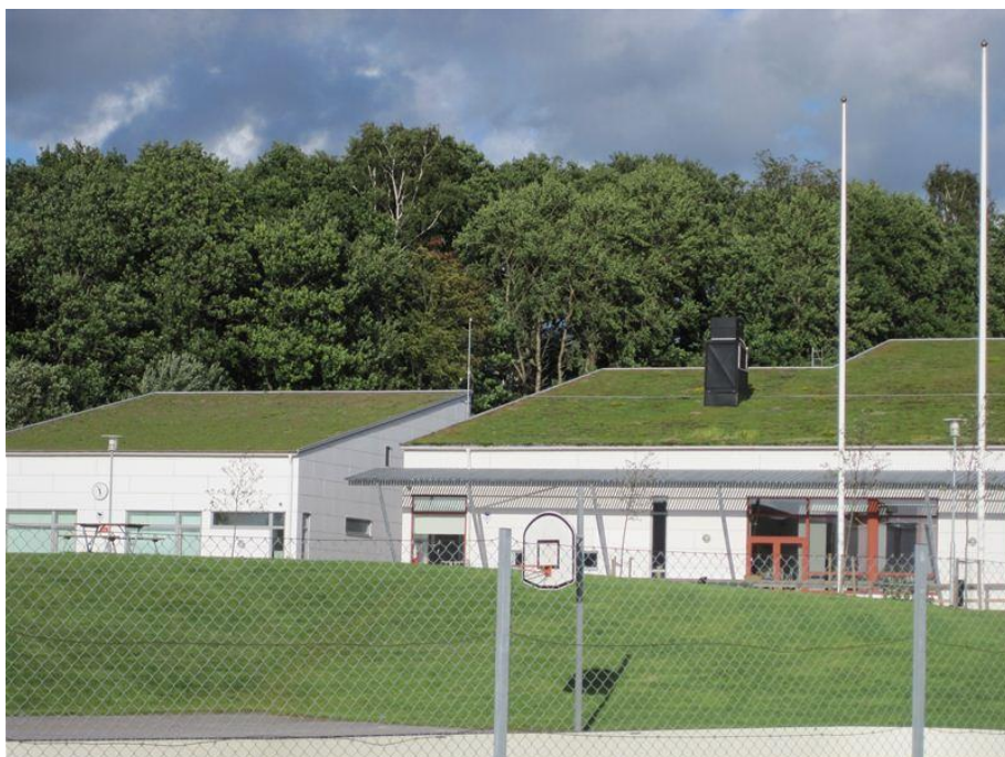
Figur 1. Vittraskolan i Kungsbacka, ett exempel på en byggnad med grönt tak. (Foto: Veg Tech).
