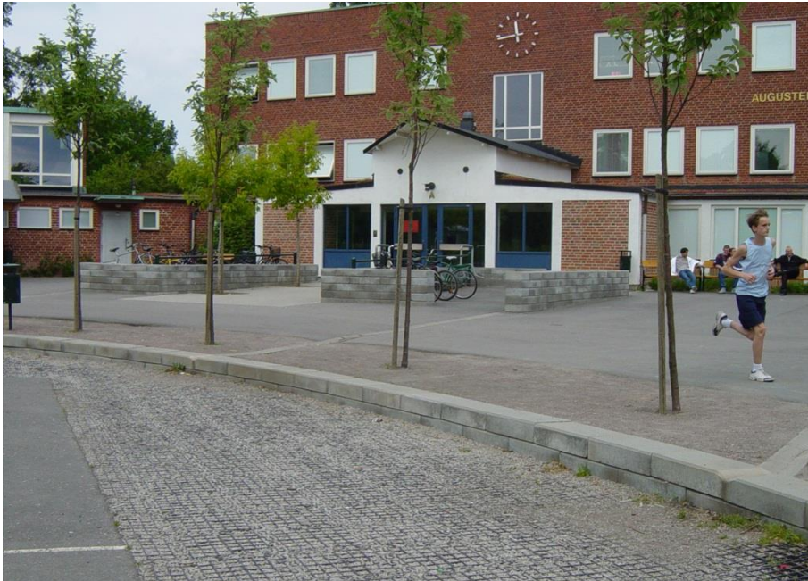
Figur 3. Del av en basketplan som vid nederbörd används som utjämningsmagasin. (Augustenborg, Malmö)
