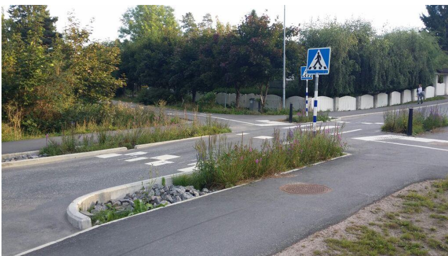
Figur 6. Biofilter för utjämning och rening av dagvatten, Tyresö.
