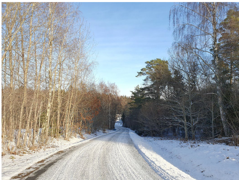
Dalgatan sett mot norr ner mot reningsverket. Foto Habo Kommun 2023-02-06.
