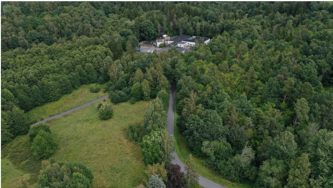
Flygfoto över planområdet. Reningsverket ligger inbäddat i grönskan i Hökesåns dalgång. Dalgatan närmast i bild, Habo kommun 2023-08-10.
