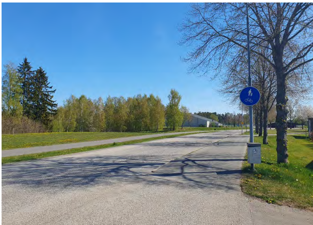
Gång- och cykelväg norr och söder om Munkvägen, Habo kommun 2023-05-12
