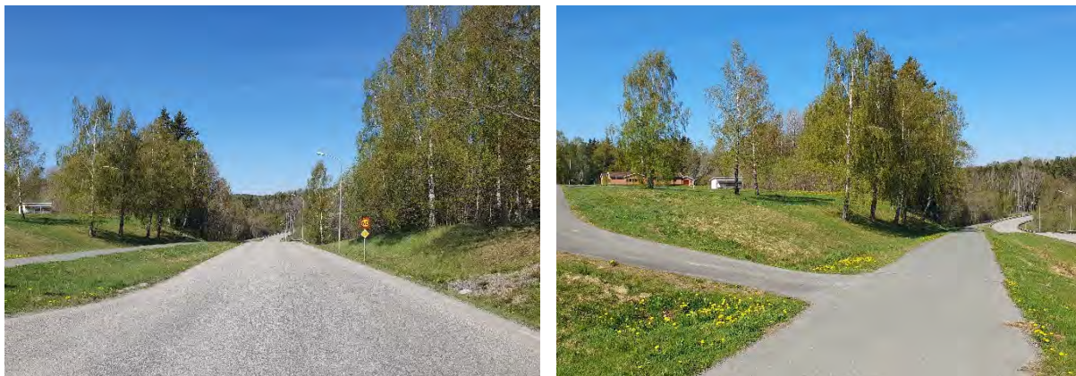
Kråkerydsvägen med separerad gång- och cykelväg, Habo kommun 2023-05-12
